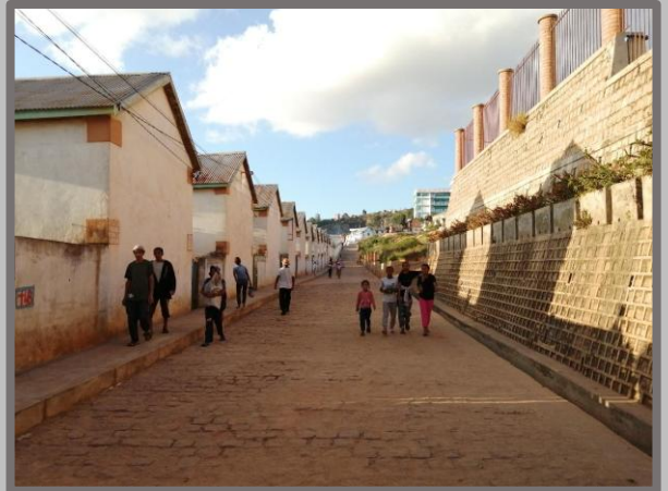
Route pavée à Tolotra
