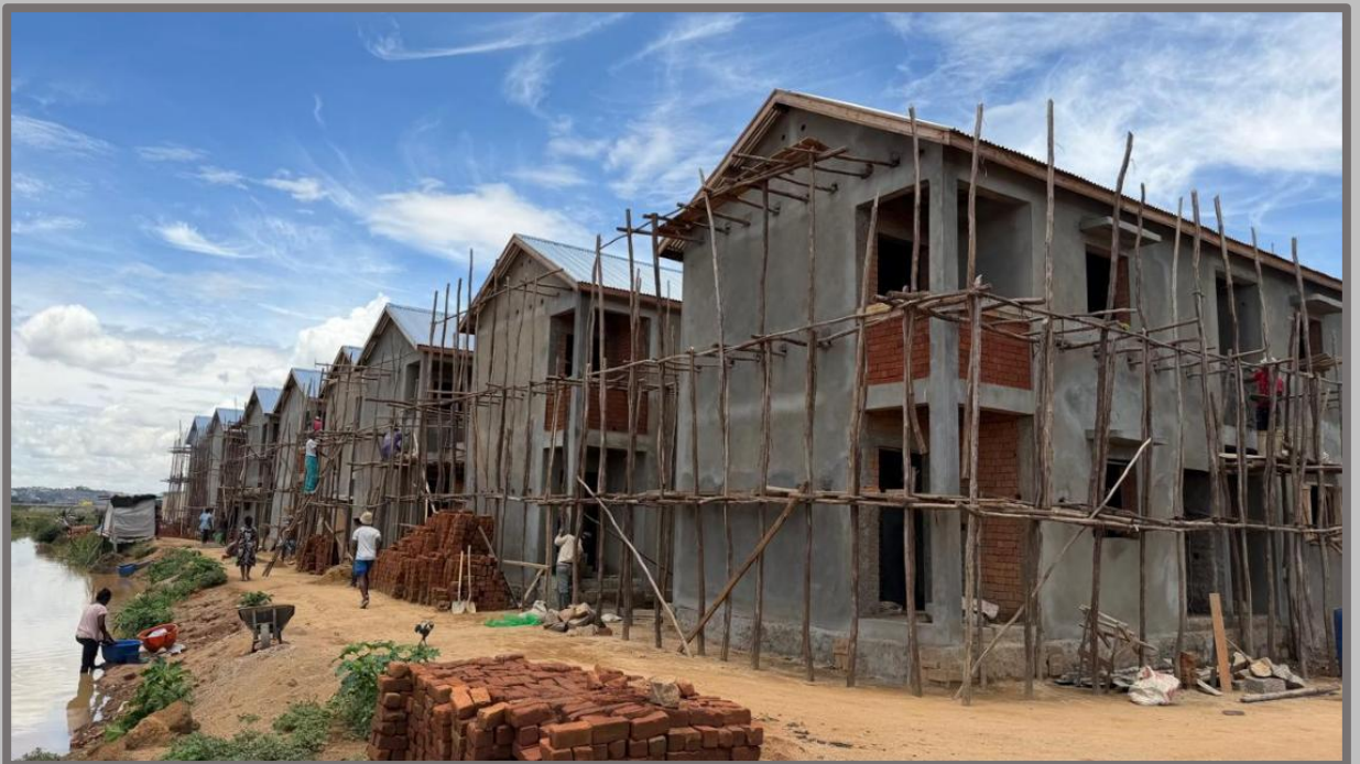
Construction de logements à Ampasika
