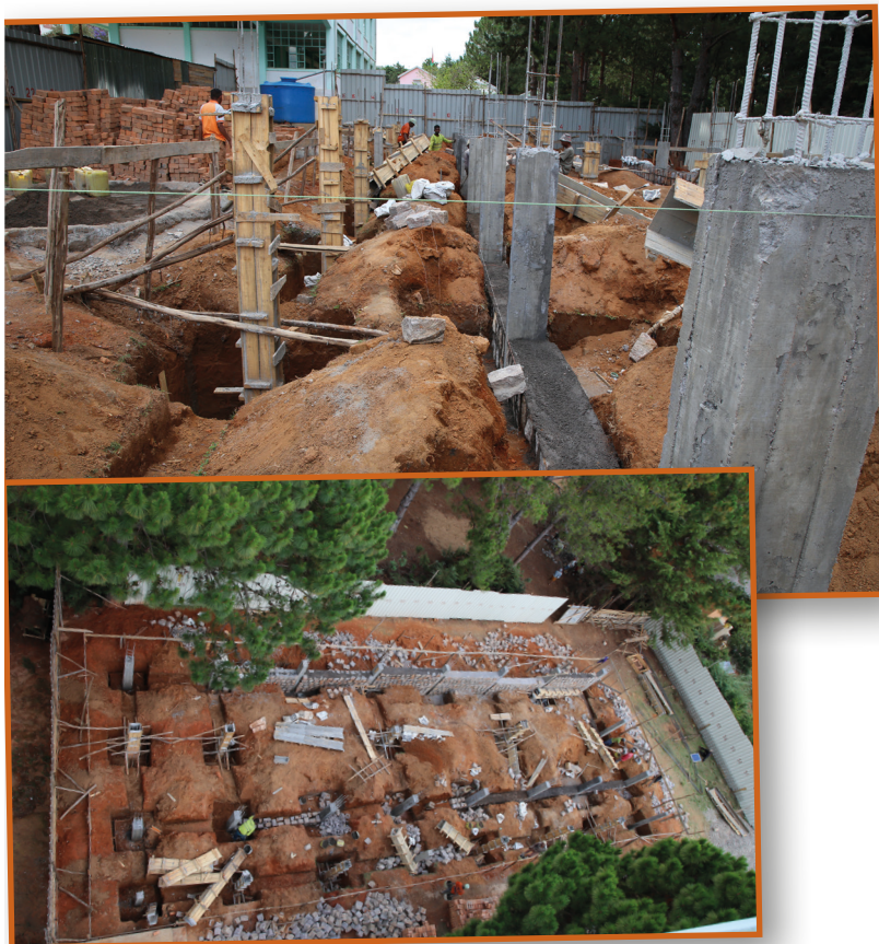
Images du chantier de la bibliothèque - Crédit : François Gouraud
