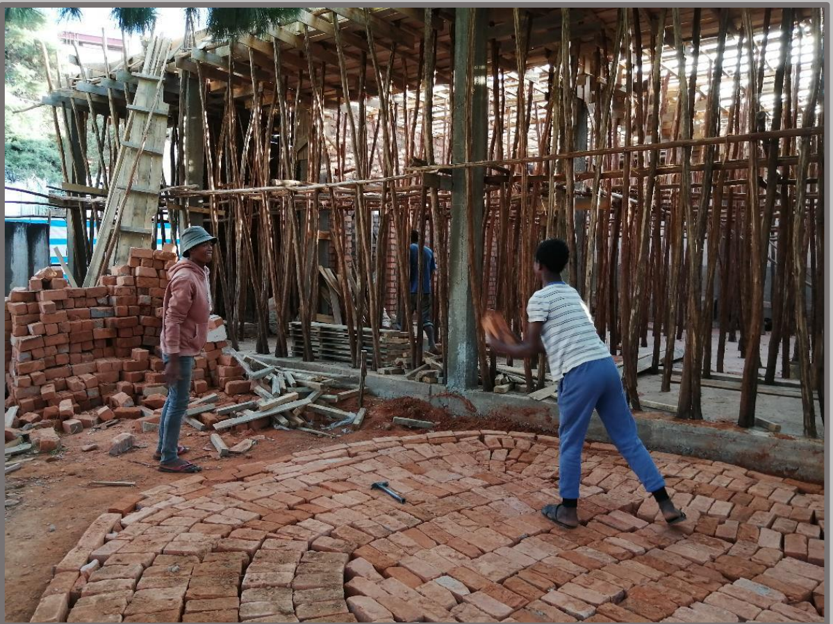
Construction d'une maison pour les femmes isolées en partie financée par l'Ambassade de France à Madagascar
