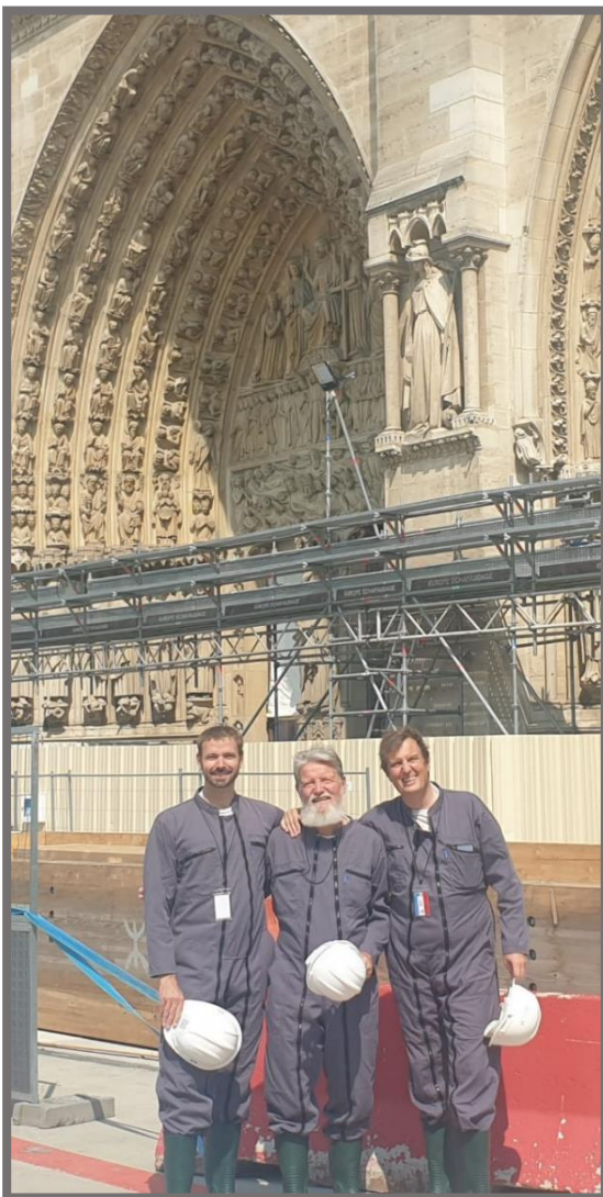
03/07/2023 : visite du chantier de Notre Dame de Paris avec Jérôme Chartrier, président des Entretiens de Royaumont.
